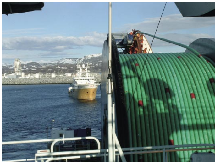
Pokládání podmořského produktovodu pro dopravu CO 2 mezi pobřežním terminálem v severním Norsku a plynovým ložiskem Snohvit v Barentsově moři (publikováno s laskavým svolením firmy Statoil)
