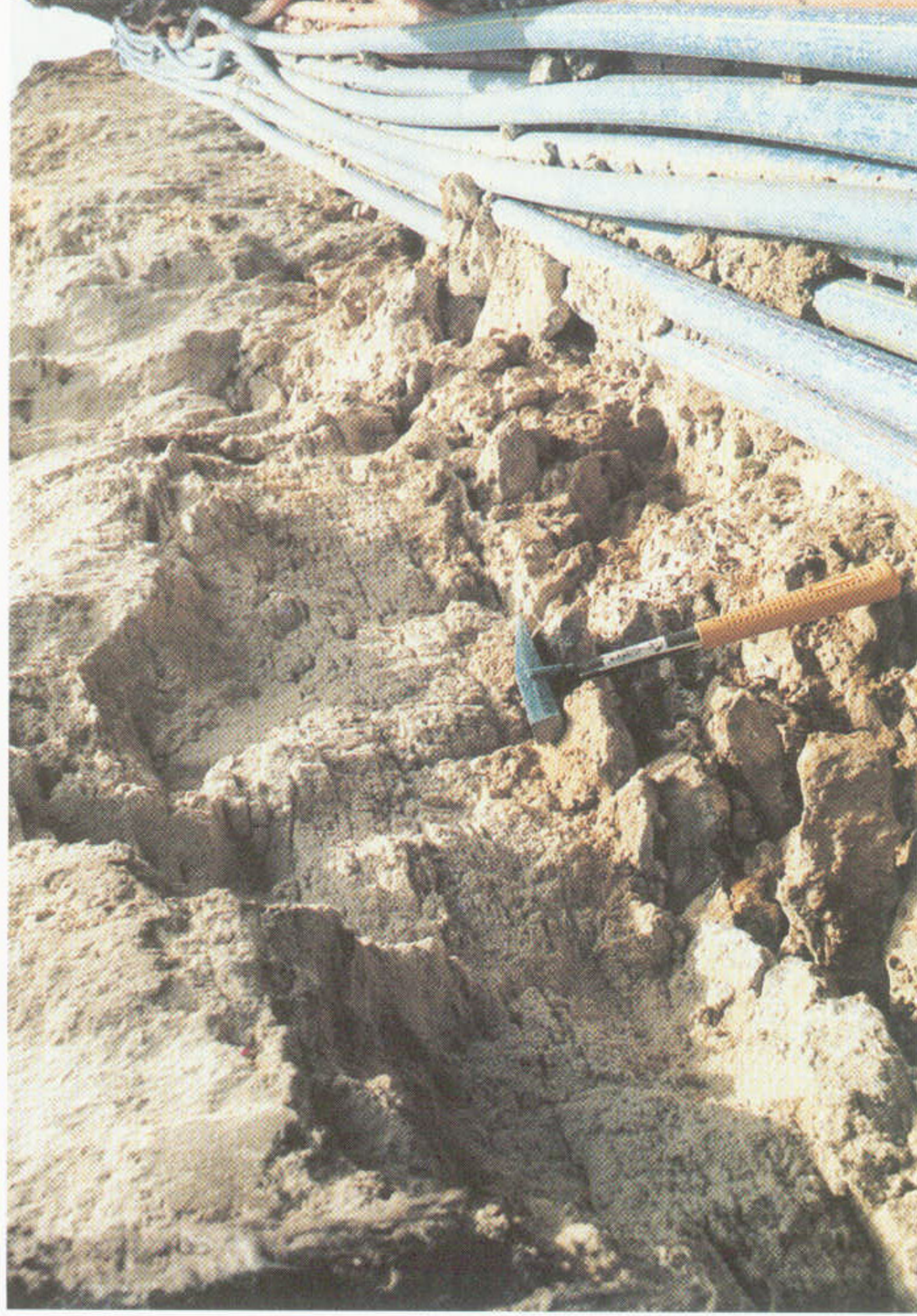
3. Místo C profilu, pohled výkopem k jihu. Prořezaný písek (v mocnosti délky kladiva, tj. 30 cm), v nadloží s intaktním, tence lavičkovitě zvrstveným pískovcem. Foto J. Žítt, červenec 2001.
