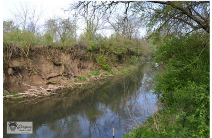
Obr. 3 Další úsek toku s výraznější erozí
