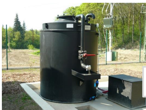
FOTO Č. 19 - NÁDRŽE NA SÍRAN ŽELEZITÝ, LIKVIDACE FOSFÁTŮ
