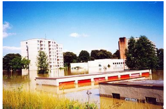
Obr. 6 Garáže ve Staré Tenici (výška vody dosáhla 179 cm)
