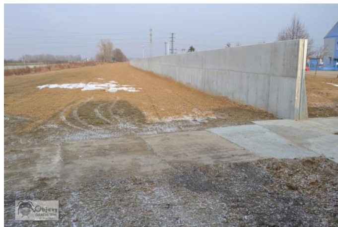
Obr. 14 Protipovodňová stěna oddělující Baťův kanál od Rybáren
