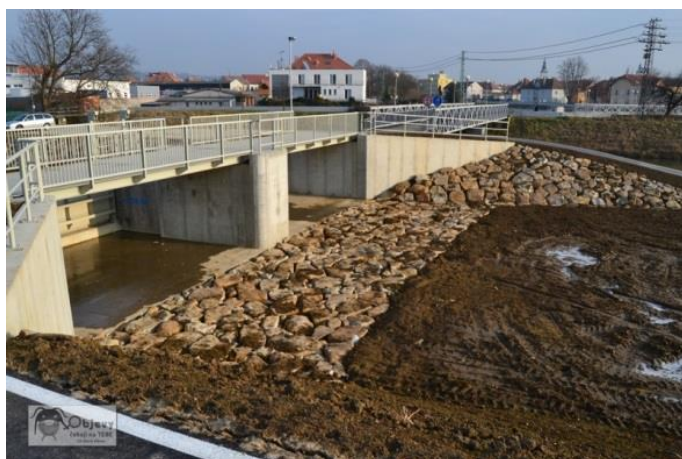
Obr. 15 Nové ochranné uzavírací zařízení na Baťově kanálu
