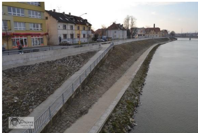
Obr. 12 Protipovodňová stěna na hradištském břehu
