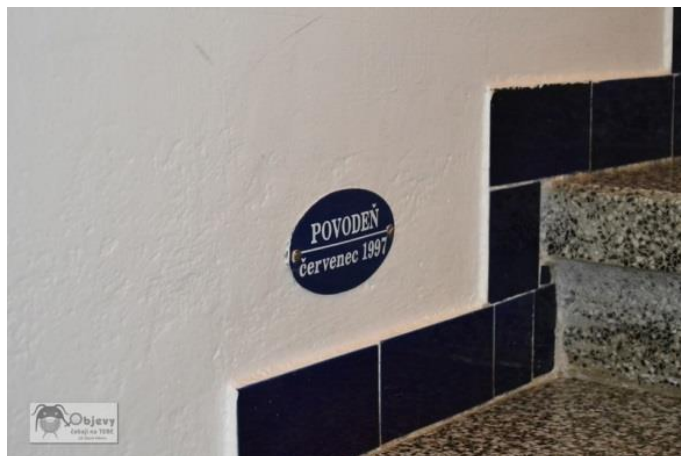
Obr. 10 Štítek na chodbě jednoho z domů (poslední schod)
