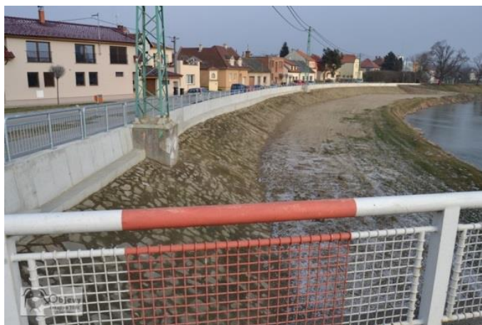
Obr. 11 Protipovodňová stěna u Rybáren
