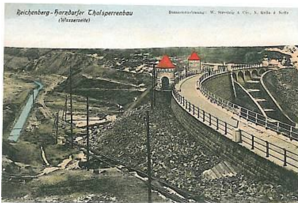
Obr. 4.: Historický snímek ze stavby přehrady. Již z té doby můžeme vidět dvě typické hrázní věžičky, ty se v téměř nezměněném stavu dochovaly dodnes.
