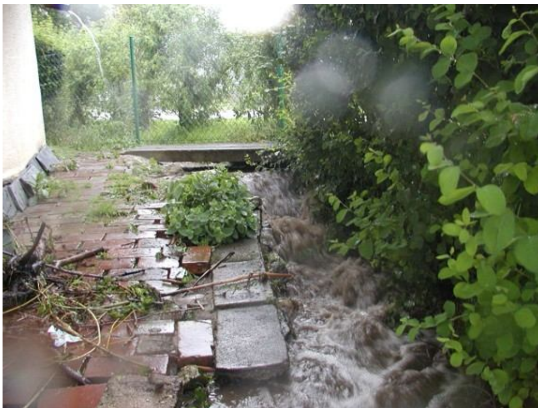
Obr. 7.: Fotografie zachycující podzemní plotu (betonová podezdívka) zahrady a poškození chodníku u domu.
