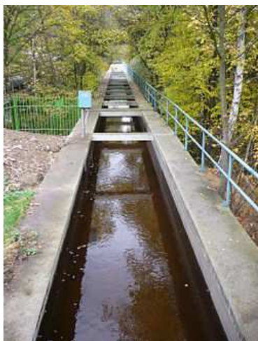
Akvadukt přivaděče přes Chomutovku
