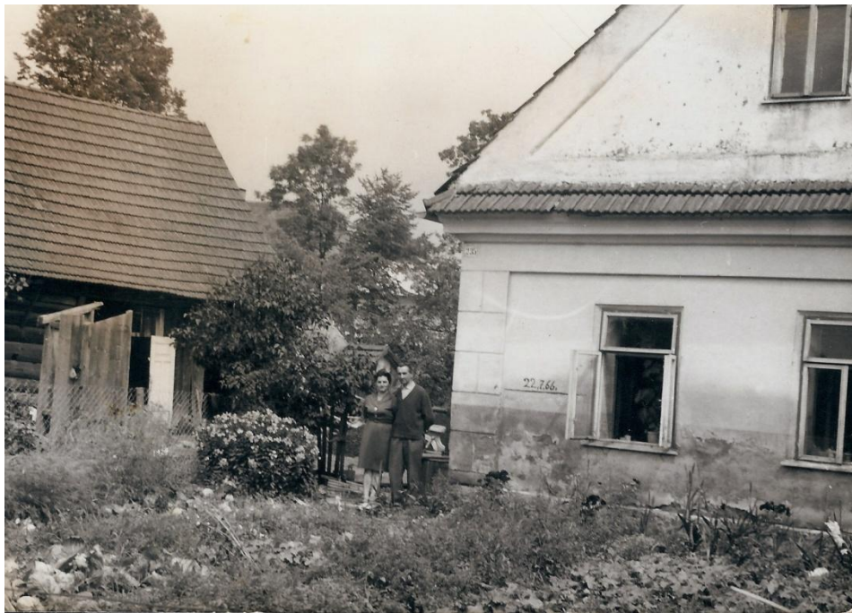
Foto 8: V roce 1966 sahala hladina vody do půlky oken – viz ryska na zdi s datem
