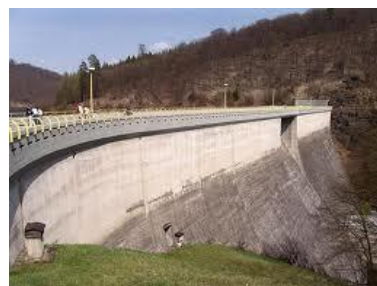
FOTO Č. 36 - HRÁZ VODNÍHO DÍLA
