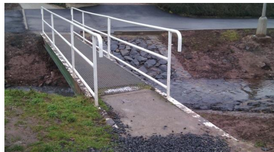
Obr.č.4 Opravené koryto potoka
