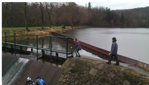
Obr.č.8 Protipovodňový přepad
