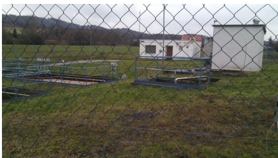
Obr.č.5 Lubenecká čistíčka odpadních vod
