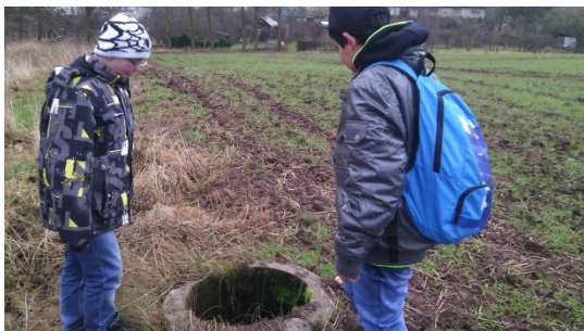
Obr.č. 30 Nechráněné větrací šachty čističky
