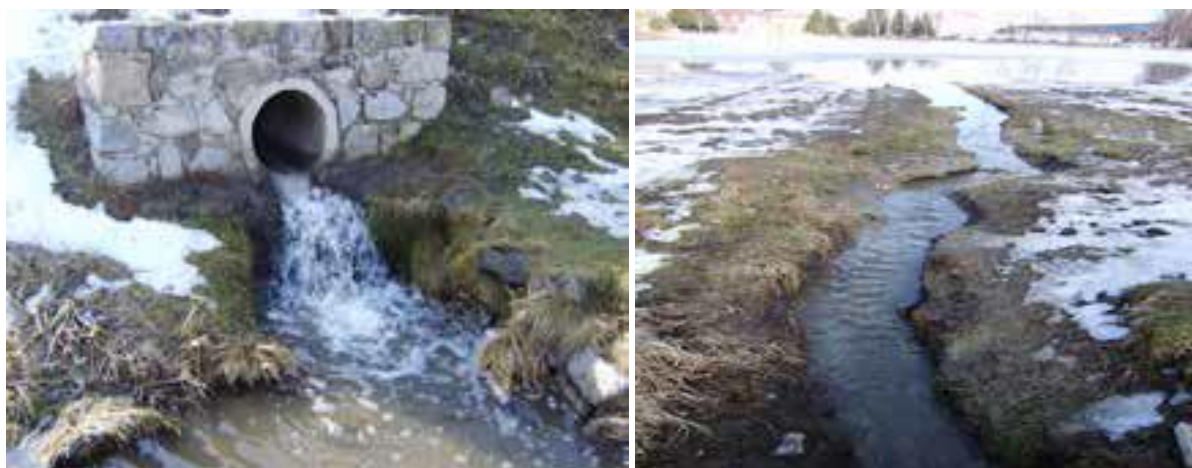
Potůček na Pražské ulici vytékající z potrubí se vlévá do rybníka Cihelna (vlevo). Pak opět mizí v podzemí a vytéká až Na Rybníčku a vlévá se do Hadiny (vpravo).
