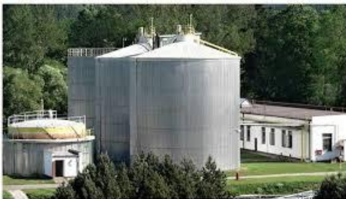
Obr. 11 Čistička odpadních vod
