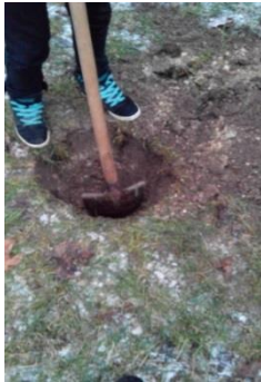
FOTO Č. 2 – VYKOPÁNÍ SONDY
