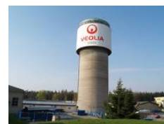
FOTO Č.5 – VODOJEM KLADNO
