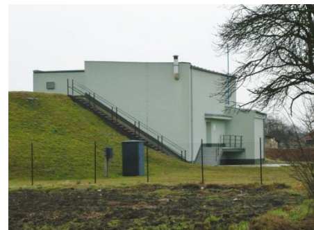
FOTO Č. 31 – ZEMNÍ VODOJEM PCHERY - THEODOR
