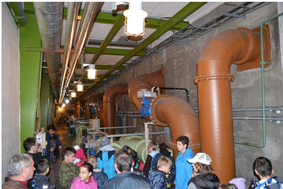
Exkurze do úpravný vod Stanovnice (Karolínka)
