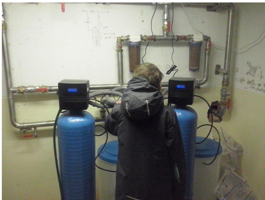
Průzkum úpravy vody bytového domu
