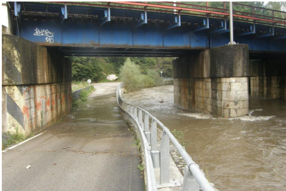
Časté zatopení přístupových cest k Adamovu. Foto září 2014
