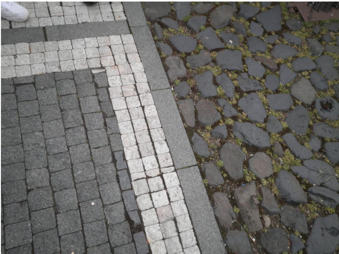
Dlažba na náměstí TGM
