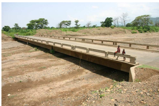
Obr. 9. Říční koryto u Arba Minch zanesené štěrkovými usazeninami.
