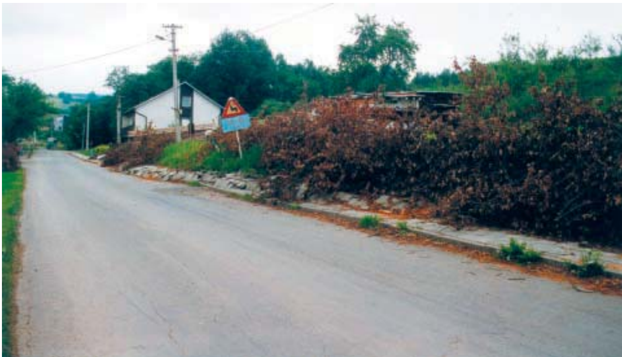
Obr. 75. Čelo rozsáhlého a nebezpečného sesuvu v obci Mikulůvka v okrese Vsetín
