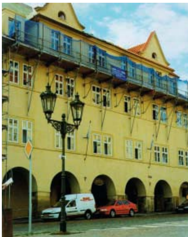
Obr. 2. V 1. patře budovy na Loretánském náměstí na Hradčanech sídlila část ústavu ve dvacátých letech
