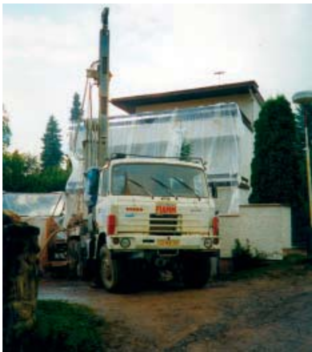
Obr. 66. Příklad využití geotermální energie k vytápění rodinného domu. Vrt byl hlouben v Jevanech v říčanské žule
