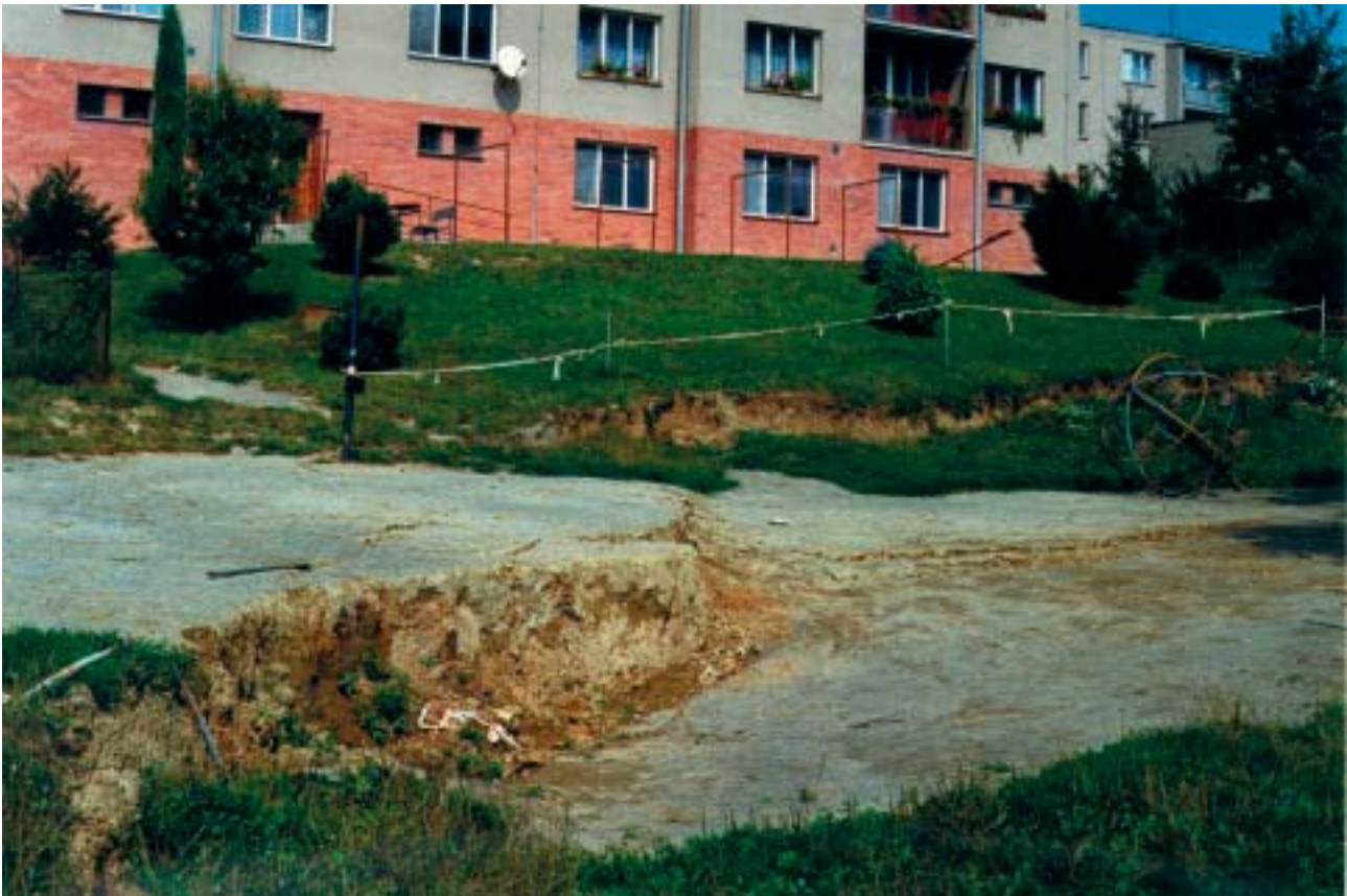
Obr. 73. Po povodních v červenci 1997 došlo k sesuvu i přímo na sídlišti v Bučovicích v okrese Vyškov
