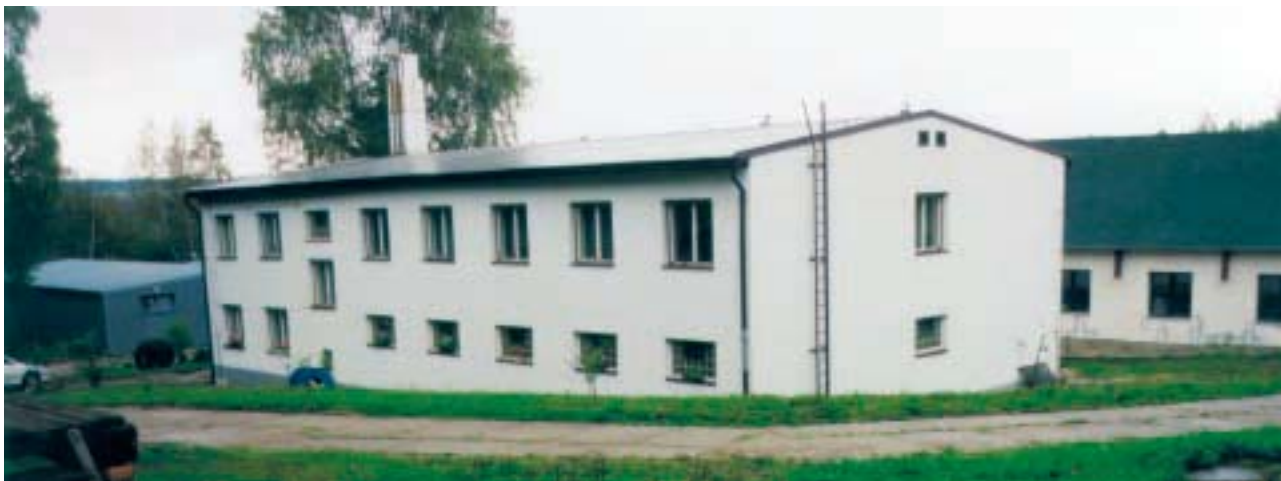
Obr. 25. Budovy skladu v Lužné u Rakovníka byly v devadesátých letech rekonstruovány. Je v nich uložen dokumentační materiál, část knihovních a mapových fondů, jakož i publikace
